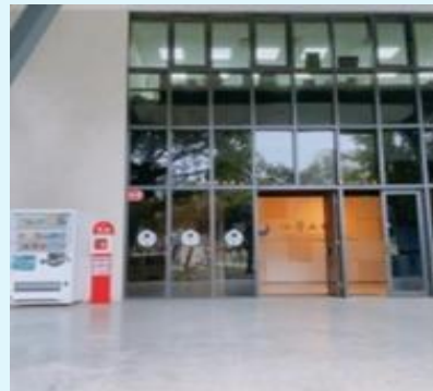
E 2 工程二館
