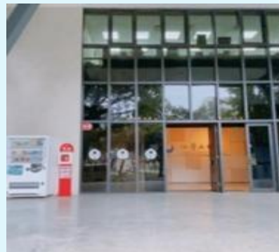
E 2 工程二館
